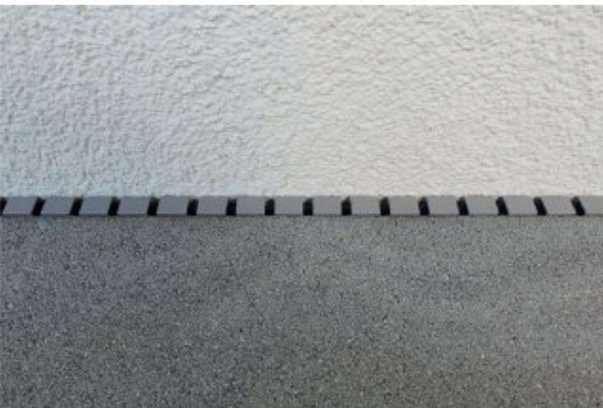
Gesicherter Feuchtigkeitstransfer entlang der Fassade.
